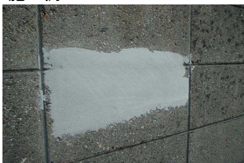
施工例 ブロック目地埋め
